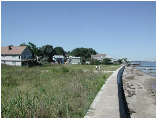
A seawall abuts the Mallard Road Marsh
